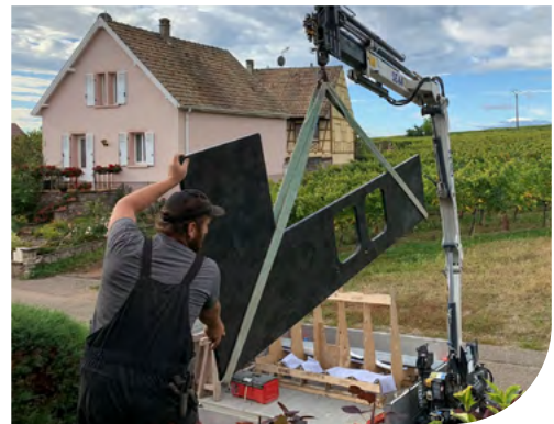
Manutention à l'aide d'une grue
