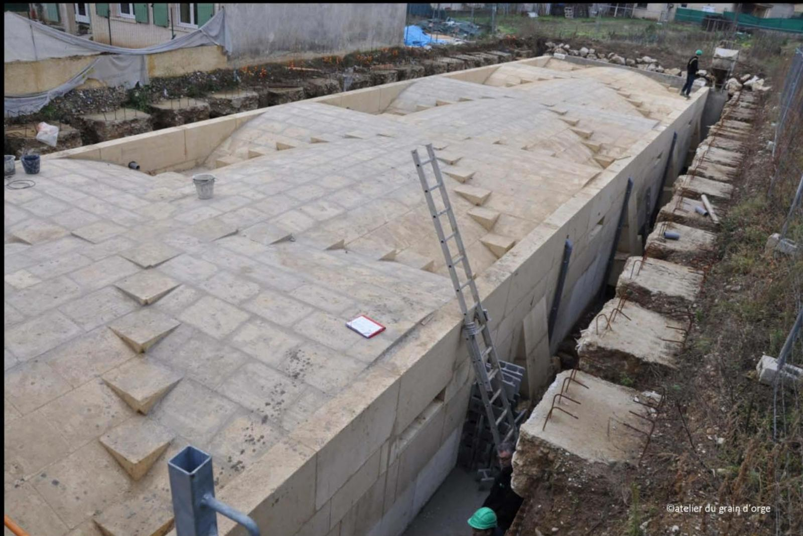
A ce stade, la voûte est fermée. Il est nécessaire de caler les murs avec du gravier compacté et de charger les reins de la voûte avant le décintrement de l'ouvrage.
