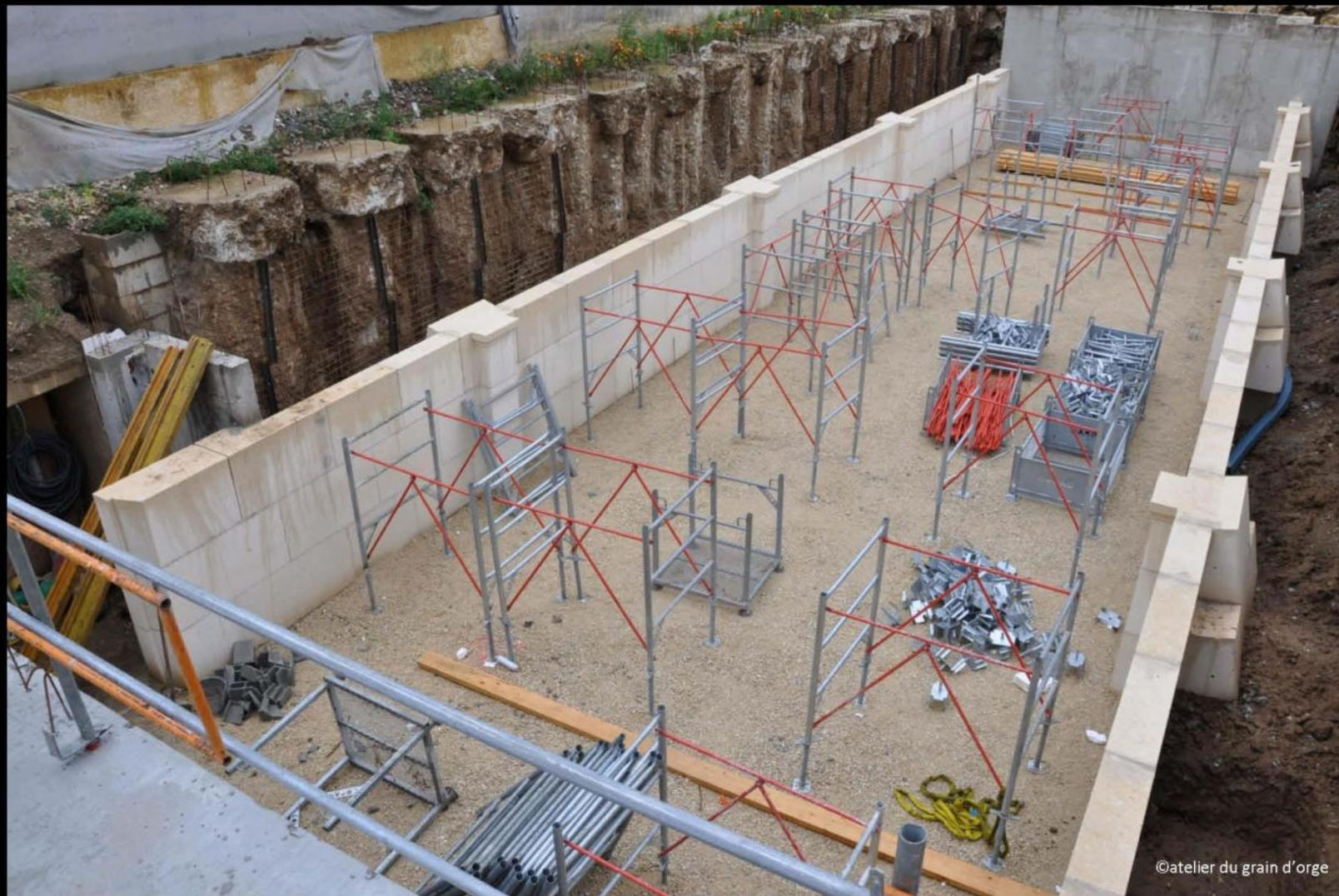
Après réalisation des fouilles, les murs sont élevés, le montage de la structure d'échafaudage commence.
