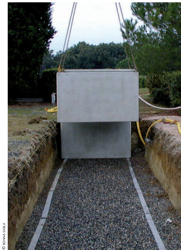
Caveau posé sur longrines avec sous couche drainante
