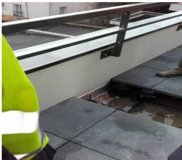
Photo n° 2 : Acrotère bas en briques à bancher de terre cuite avec rehausse métallique
