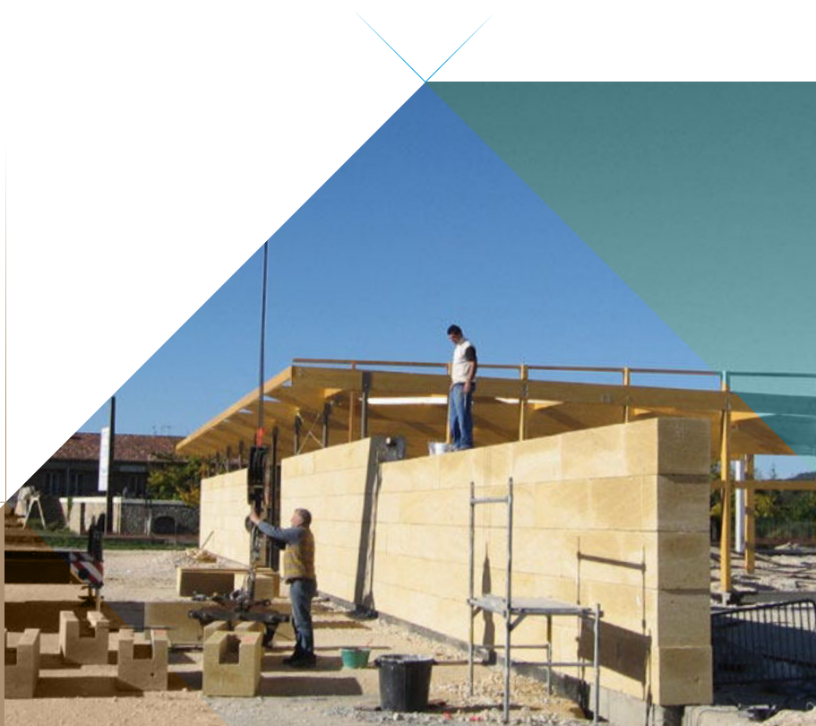
Figure 1 Réalisation d'un ouvrage en pierre naturelle
