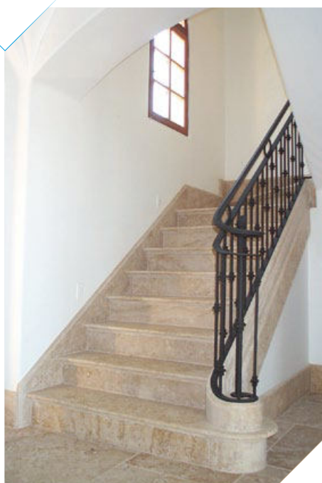
Figure 10 - Revêtement de sol scellé
