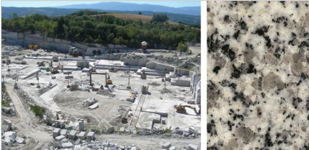
Figure 14 – Carrière de Granit du Tarn à Saint-Salvy-de-la-Balme (81) – Photos www.plo.fr & Editions Pro Roc.
