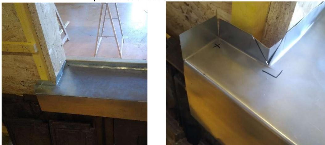
Photographie 2 : détail de bavette basse sur pièce d'appui, avant la mise en place d'un gousset soudé sur l'angle (gauche) et mise en place du gousset à souder et soudures à faire (marques) (droite)
