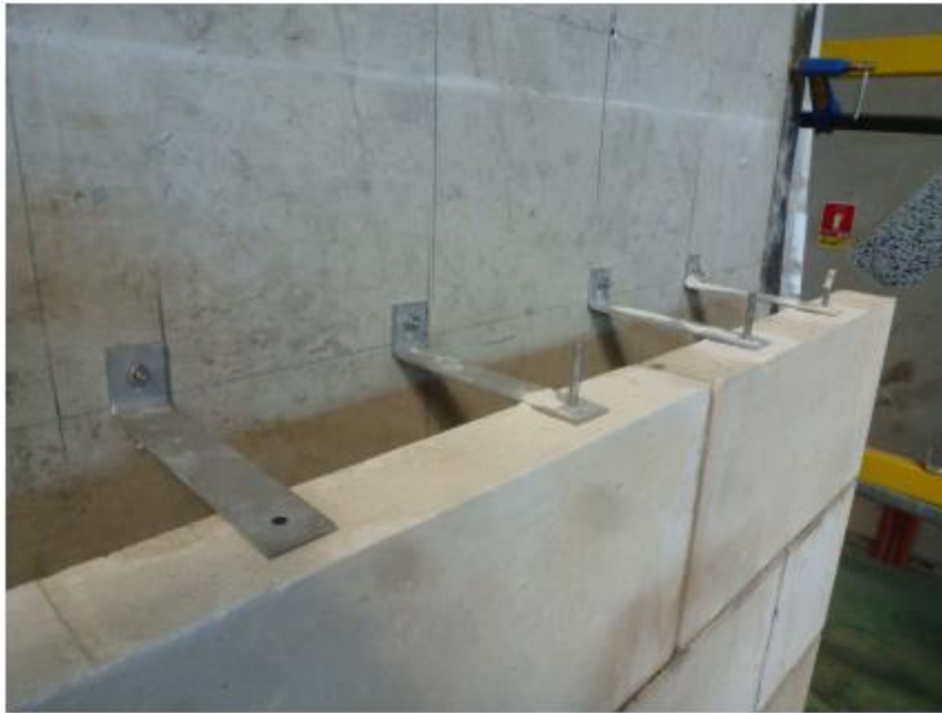
PHOTO PRISE EN COURS DE MONTAGE DU MUR DE PAREMENT TESTE
