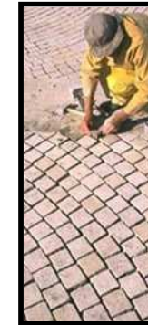
Pavé de voirie Calcaire de Roquemailière Granit de Louvigné du Desert
